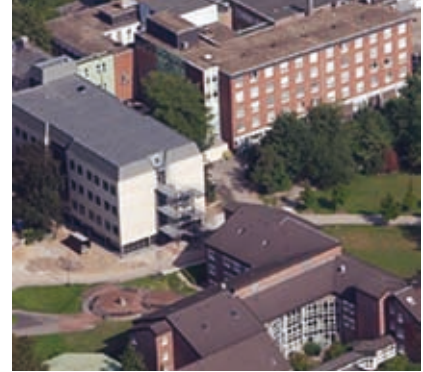
Im Bild oben das ehemalige Krankenhaus Maria-Hilf, unten das ehemalige Alexianer-Krankenhaus. Beide zusammen sind ab 2009 die Krankenhaus Maria-Hilf GmbH Krefeld.
